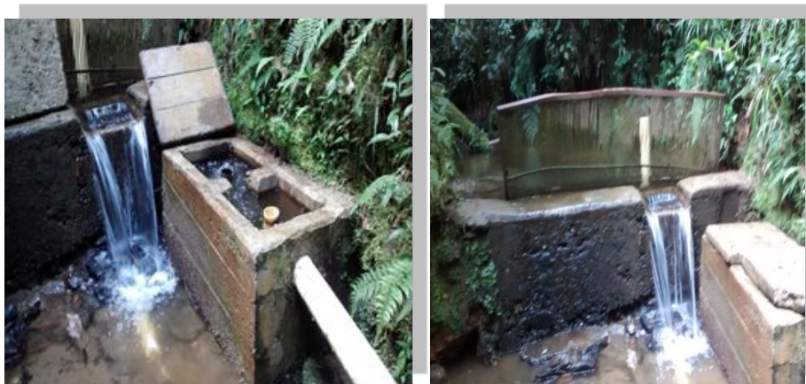
Figura N° 2 y 3. Zona de captación.
